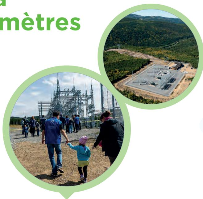
Le **poste de raccordement** augmente la tension au niveau requis afin de pouvoir relier le réseau collecteur des parcs éoliens au réseau d'Hydro-Québec.
